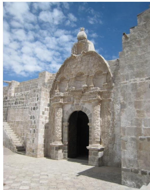
A diferencia de Lima o Cusco, las portadas barrocas arequipeñas se colocan sobre el muro plano, sin recurrir a planos adelantados ni traspilastras. La forma planiforme y textilográfica en que se talla el sillar, caracteriza a la Escuela. Imágenes: M. Fuentes, 2010
