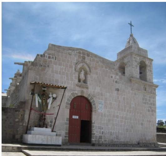
A diferencia de Lima o Cusco, las portadas barrocas arequipeñas se colocan sobre el muro plano, sin recurrir a planos adelantados ni traspilastras. La forma planiforme y textilográfica en que se talla el sillar, caracteriza a la Escuela. Imágenes: M. Fuentes, 2010
