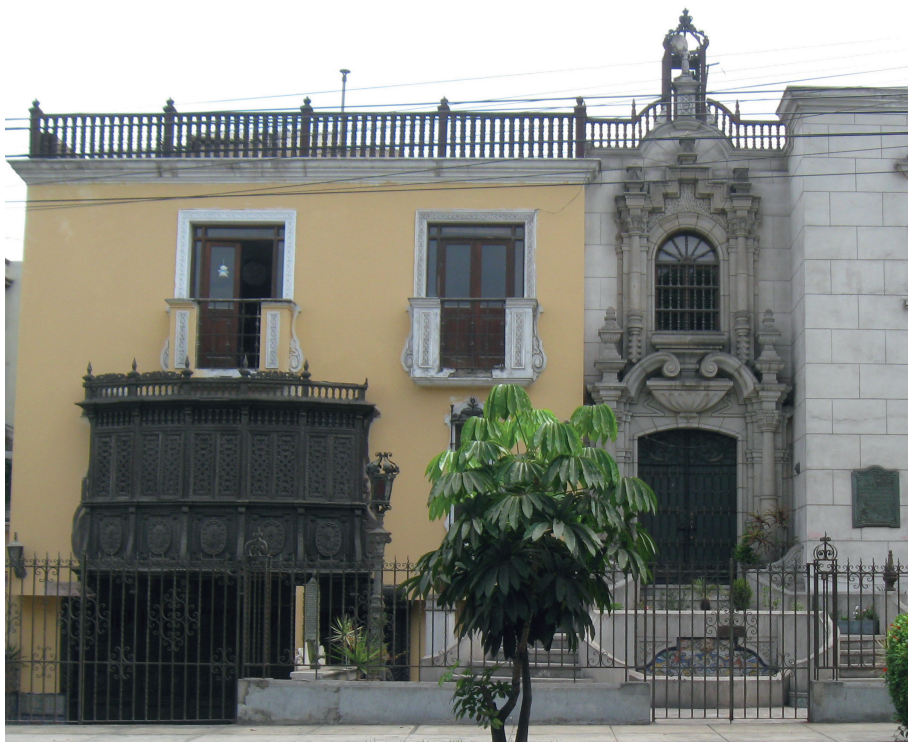
La “Casa de la Tradición”, en la avenida Salaverry N° 3052. Edificada en 1960, intentó infructuosamente revivir el movimiento neocolonial, recibiendo merecidas críticas por el anacronismo de su propuesta. En 2010 fue finalmente demolida. Fuente: Julia Loli y Claudia Moreno, 2009.
