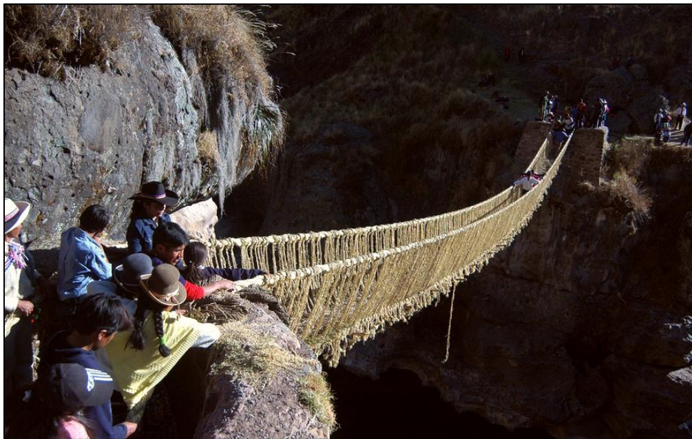
Figura 9: El puente de Q'eshwachaca (región de Cusco, Perú) se reconstruye anualmente con la Participación de las comunidades de la zona. Año tras año, se reproducen técnicas y ceremonias de origen puramente andino.
