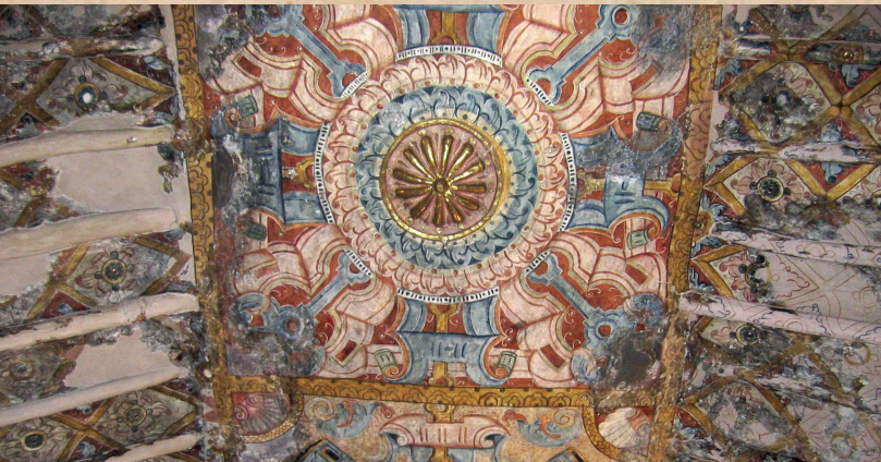
Cusco: armadura de la cubierta de la iglesia de la Virgen Purificada de Saylla (siglo XVII)
